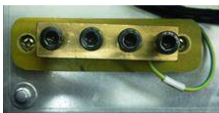
Generator Grounding Bar Lug
